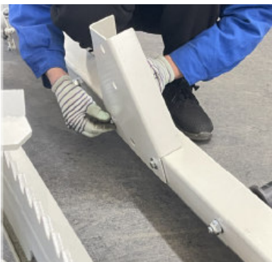
Abb. 5-14: Montage unterer Querträger mit Winkelplatten
