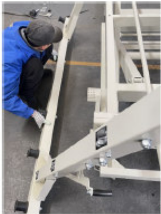
Abb. 5-12: Montage der Querträger
